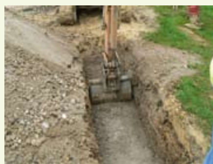
Mise en place de matériaux issus de traitement à la chaux
